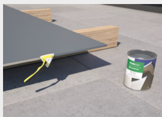
Auftragen der ColourPlus™ Kantenversiegelung vor der Montage
