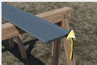
Auftragen der HardieSeal™ Kantenversiegelung vor der Montage.
