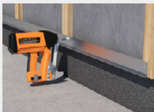
Befestigung des Sockel-Lüftungsprofil.
